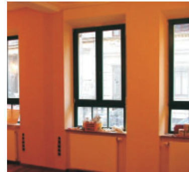
Innendämmung bei einem Gründerzeitgebäude 6 – 12 cm dick.
