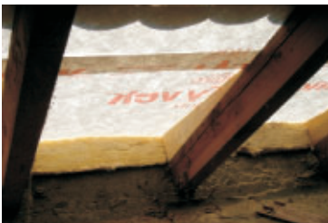
Wärmebrückenminimierung an der Traufe mittels Aufschiebling.
