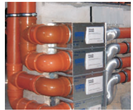
Abluftgeräte für vier Wohnungen [Aerex 2004].
