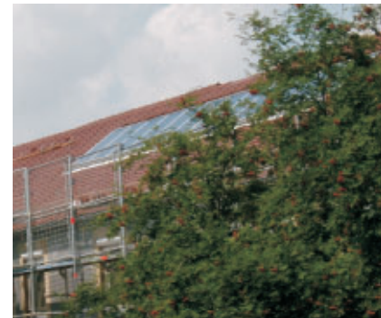
Optimierung durch den Einsatz von Solarthermie.
