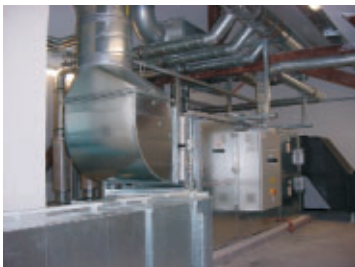
Zentrale der Zu-Abluftanlage.
