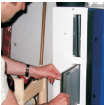
Filterwechsel: möglichst einfach (durch den Mieter)/kostengünstige Ersatzfilter.
