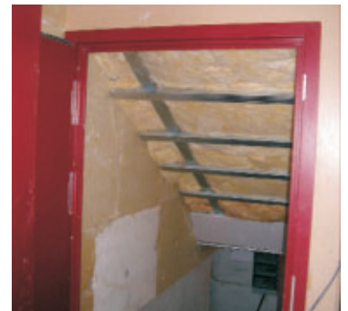
Kellerabgang: Wärmebrückenarm und luftdicht.
