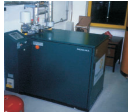
Günstig für den Anlagenaufwand: Einsatz von Kraft-Wärme-Kopplung.
