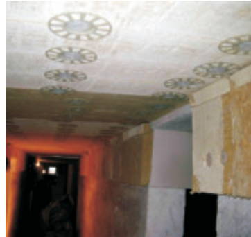
Dämmung der KG-Decke mit Mineralfaserdämmung 20 cm dick.
