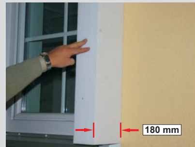
Herkömmliches Passivhaus-Dämmsystem > 180/300 mm je nach Dämmstoff
